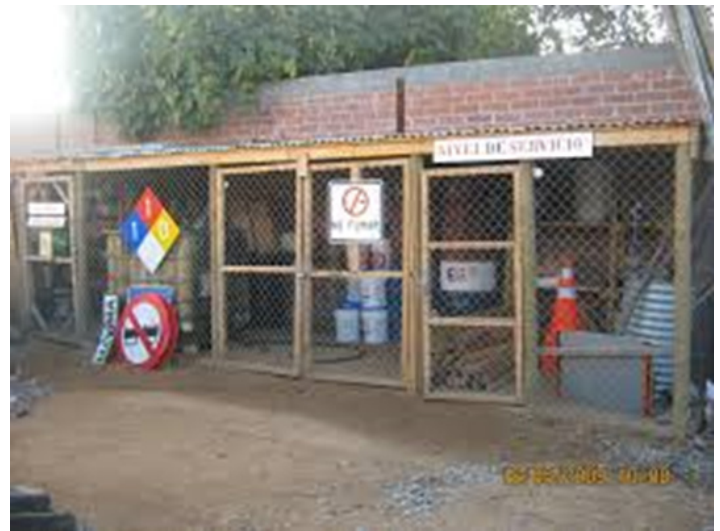
Figura N° 25 Almacenamiento en Lugares Ventilados.
